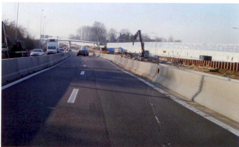
Ophoogwerkzaamheden aan de A15 in januari 2005.
